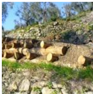
Figura 36 Creazione rampe di accesso con strutture amovibili
