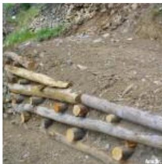
Figura 37 Creazione rampe di accesso con strutture amovibili
