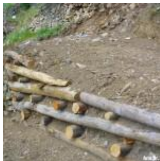
Figura 26 Creazione rampe di accesso con strutture amovibili
